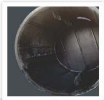
Revestimento interno de tanque com borracha Natural
